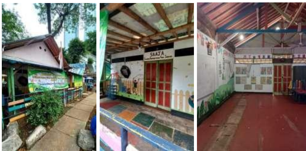
Gambar 1. Kondisi Bangunan Sekolah
